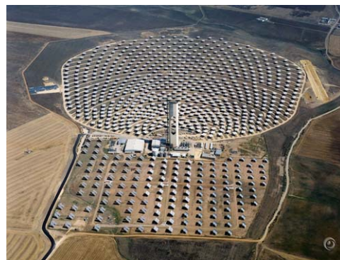
La centrale solaire de Sanlúcar la Mayor PS-10
